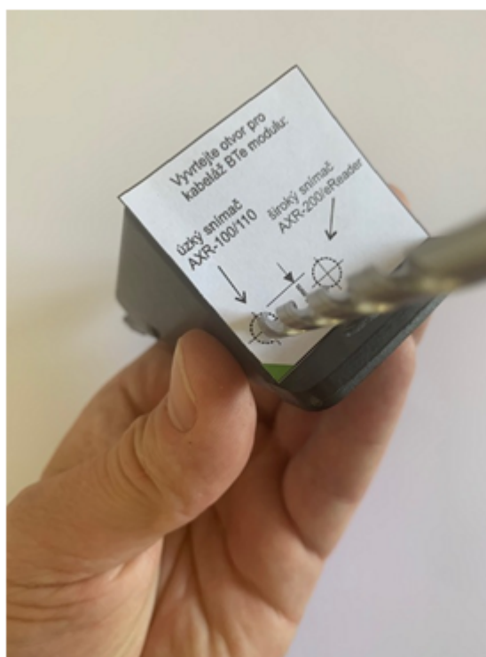
Obr. Vrtání otvoru pro úzký kryt (AXR-1xx)
